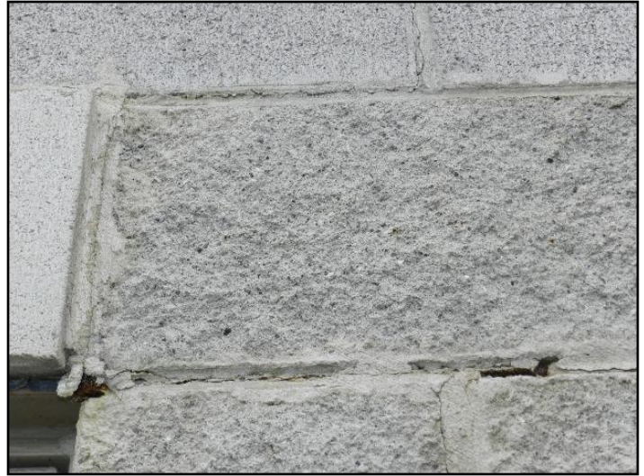
21. Mortar deterioration
