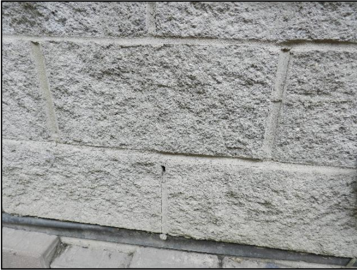
20. Mortar deterioration
